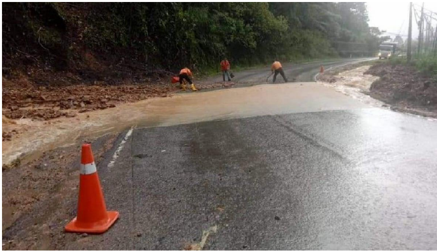
Kerja pembersihan dijalankan di kawasan runtuh. Foto Ihsan JKR
