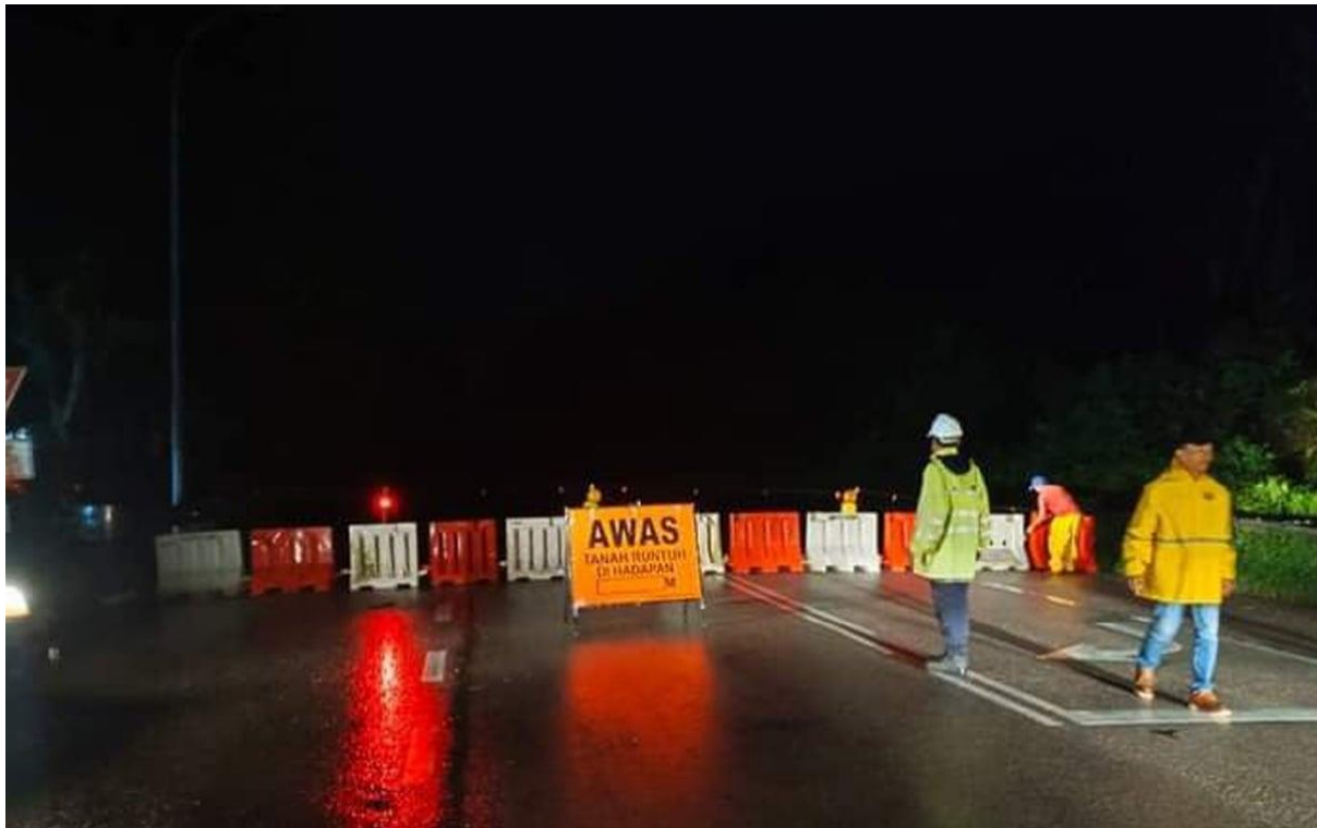
Jalan Sungai Tiram - Ulu Tebrau ditutup akibat kejadian tanah runtuh. Foto Ihsan JKR
