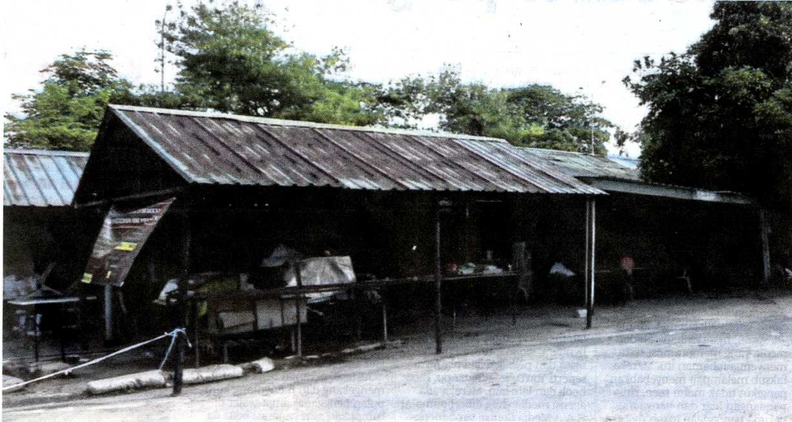
Rumah pegawai masjid yang terletak di kawasan Masjid Lapangan Terbang Subang yang hendak dirobohkan Pejabat Tanah dan Daerah (PTD) Petaling.
