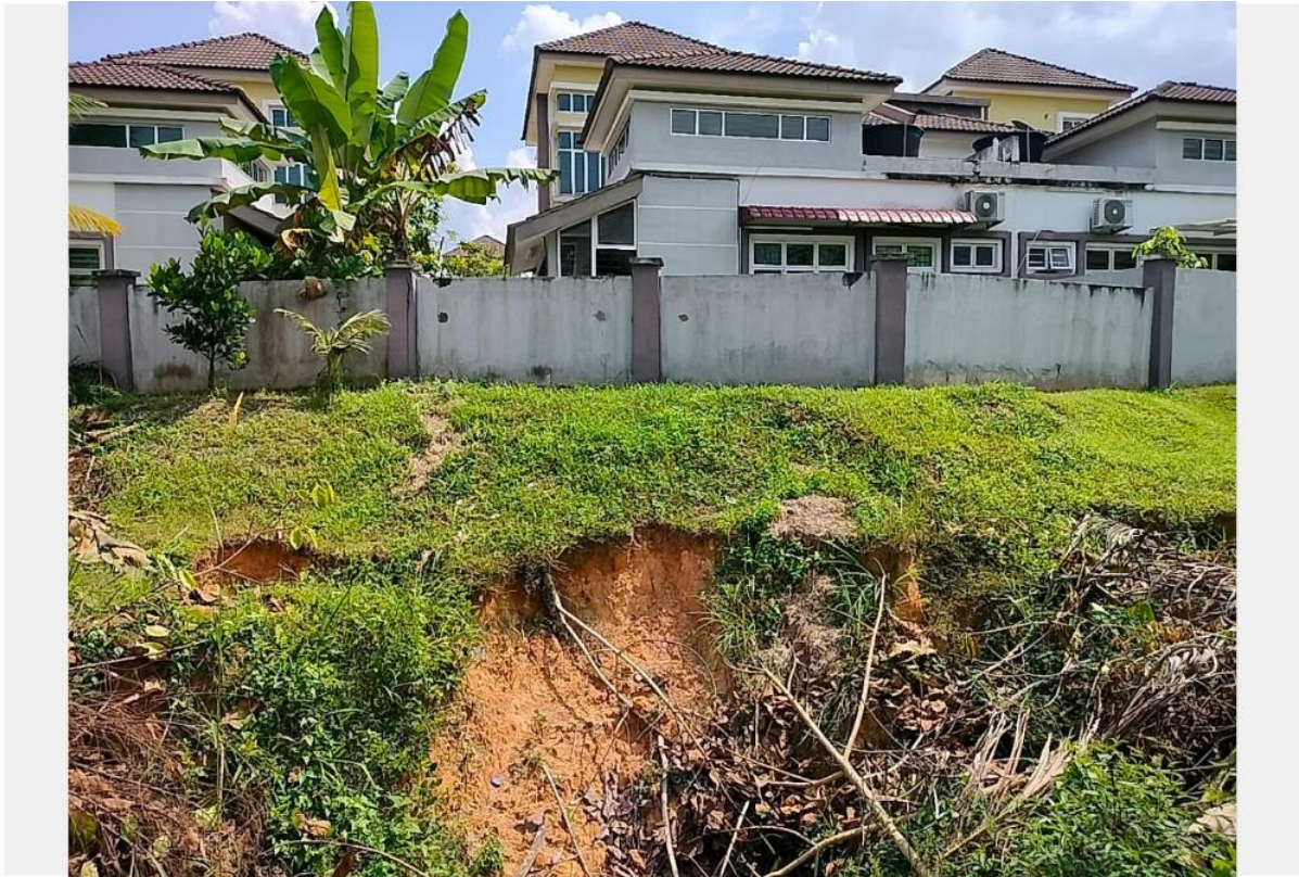
Keadaan mendapan tanah di Presint 5, Taman Warisan Puteri.
